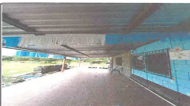
Foto 4: CORREDOR CON NUEVO PISO CERAMICO
