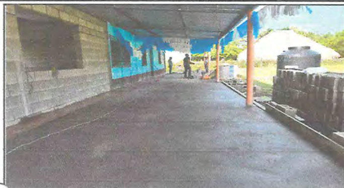
Foto 1: CORREDOR CON NUEVA TORTA DE CEMENTO
