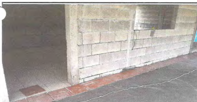
Foto 5: PARED NUEVA DE AULA
