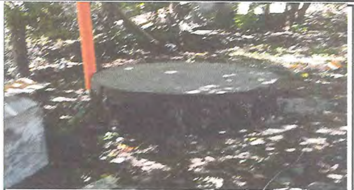
Foto 2: FOSA NUEVA CONSTRUIDA
