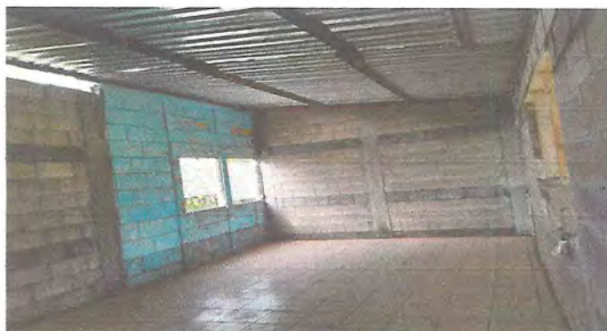
Foto 3: AULA CON PISO CERAMICO NUEVO
