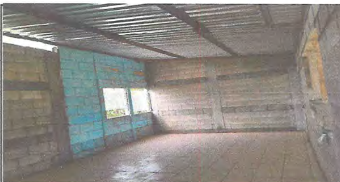
Foto 6: PARED NUEVA DE AULA
