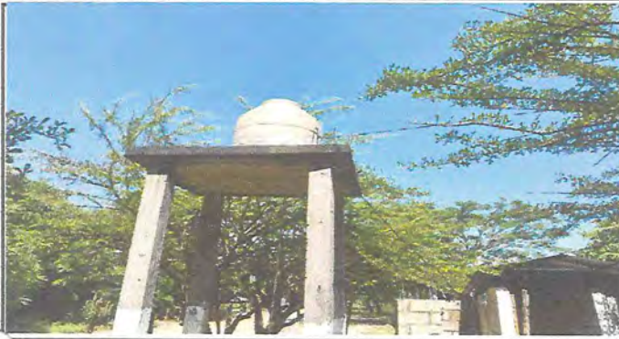
Foto 1: TINACO DE AGUA INSTALADO
